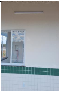
PINTURA LÁTEX ACRÍLICA PREMIUM, APLICAÇÃO MANUAL EM PAREDES, DUAS DEMÃOS. AF_04/2023
