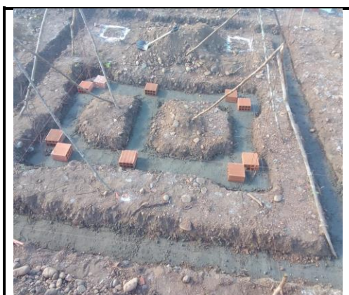
LOCALIZAÇÃO CONVENCIONAL DE OBRA, UTILIZANDO GABARITO DE TÁBUAS CORRIDAS PONTALEADAS A CADA 2,00M - 2 UTILIZAÇÕES. AF_10/2018
