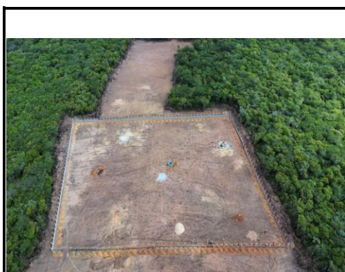
CERCA DE ARAME FARPADO 7 FIOS, MURETA C/ ALTURA DE 0,70M - FUNDAÇÃO E REBOCO NAS 2 FACES
