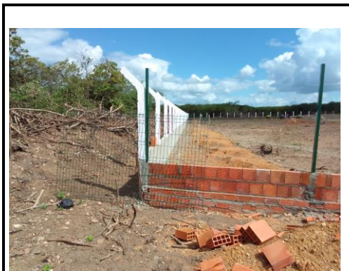
CERCA/GRADIL NYLOFOR H=1,53M, MALHA 5 X 20CM - FIO 5,00MM, COM FIXADORES DE POLIAMIDA EM POSTE 40 x 60 MM CHUMBADOS EM BASE DE CONCRETO (EXCLUSIVE ESTA) ,
