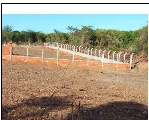
CERCA DE ARAME FARPADO 7 FIOS, MURETA C/ ALTURA DE 0,70M - FUNDAÇÃO E REBOCO NAS 2 FACES
