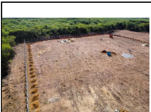
CERCA DE ARAME FARPADO 7 FIOS, MURETA C/ ALTURA DE 0,70M - FUNDAÇÃO E REBOCO NAS 2 FACES
