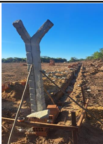
CERCA DE ARAME FARPADO 7 FIOS,MURETA C/ ALTURA DE 0,70M - FUNDAÇÃO E REBOCO NAS 2 FACES
