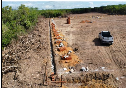
CERCA DE ARAME FARPADO 7 FIOS,MURETA C/ ALTURA DE 0,70M - FUNDAÇÃO E REBOCO NAS 2 FACES
