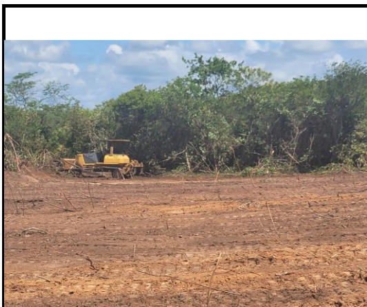
DESMATAMENTO E LIMPEZA MECANIZADA DE TERRENO COM ÁRVORES ATÉ 15CM, UTILIZANDO TRATOR DE ESTEIRAS
