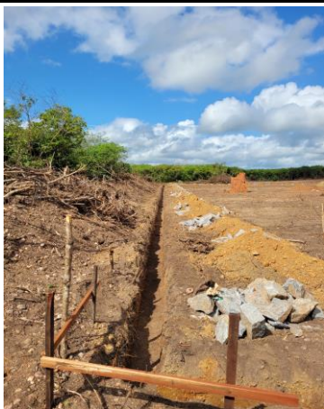
CERCA DE ARAME FARPADO 7 FIOS,MURETA C/ ALTURA DE 0,70M - FUNDAÇÃO E REBOCO NAS 2 FACES
