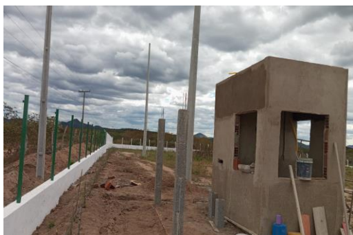
POSTE DE CONCRETO DUPLO T, RESISTÊNCIA NOMINAL 200KG, H= 8,00M, PESO APROXIMADO 400KG
