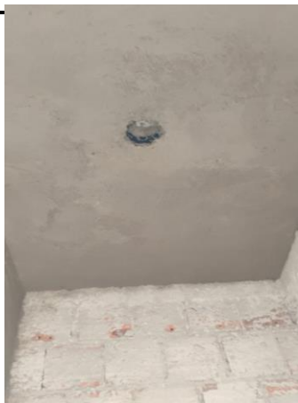
LAJE PRÉ-FABRICADA TRELIÇADA P/ FÔRRO - VÃO ATÉ 2,80 m
