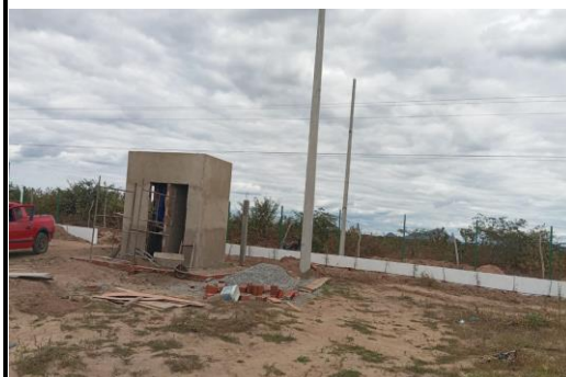
ALVENARIA DE VEDAÇÃO DE BLOCOS VAZADOS DE CONCRETO DE 19X19X39 CM (ESPESSURA 19 CM) E ARGAMASSA DE ASSENTAMENTO COM PREPARO MANUAL.
