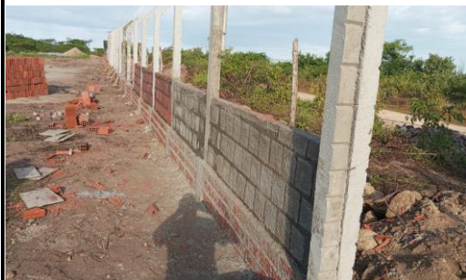
CERCA DE ARAME FARPADO 7 FIOS, MURETA C/ ALTURA DE 0,70M - FUNDAÇÃO E REBOCO NAS 2 FACES
