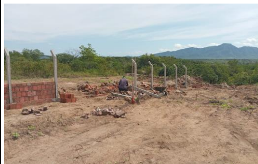
CERCA DE ARAME FARPADO 7 FIOS, MURETA C/ ALTURA DE 0,70M - FUNDAÇÃO E REBOCO NAS 2 FACES
