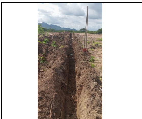
CERCA DE ARAME FARPADO 7 FIOS, MURETA C/ ALTURA DE 0,70M - FUNDAÇÃO E REBOCO NAS 2 FACES
