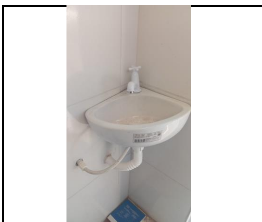
PONTO HIDRÁULICO, MATERIAL E EXECUÇÃO
