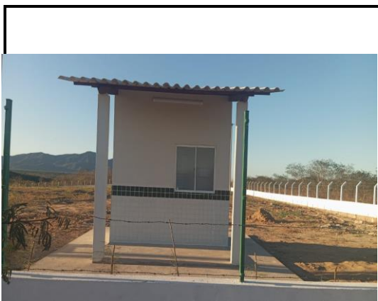
TELHA DE FIBROCEMENTO ONDULADA E= 8mm, INCLINAÇÃO 27%
