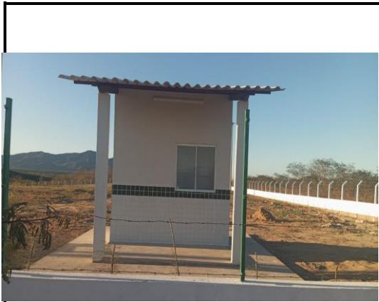
PINTURA LÁTEX ACRÍLICA PREMIUM, APLICAÇÃO MANUAL EM PAREDES, DUAS DEMÃOS. AF_04/2023
