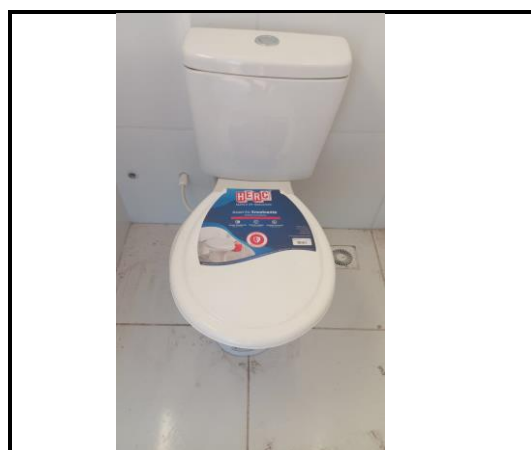
PONTO SANITÁRIO, MATERIAL E EXECUÇÃO
