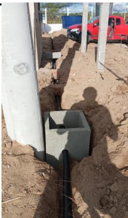
ELETRODUTO PVC ROSC. D= 60mm (2")
