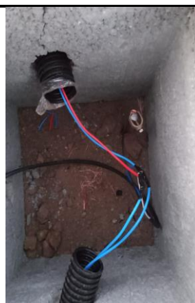
CABO DE COBRE FLEXÍVEL ISOLADO, 4 MM², ANTI-CHAMA 0,6/1,0 KV, PARA CIRCUITOS TERMINAIS - FORNECIMENTO E INSTALAÇÃO. AF_03/2023
