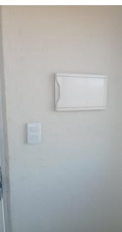
QUADRO DE DISTRIBUIÇÃO DE LUZ EMBUTIR ATÉ 12 DIVISÕES 207X332X95mm, C/BARRAMENTO
