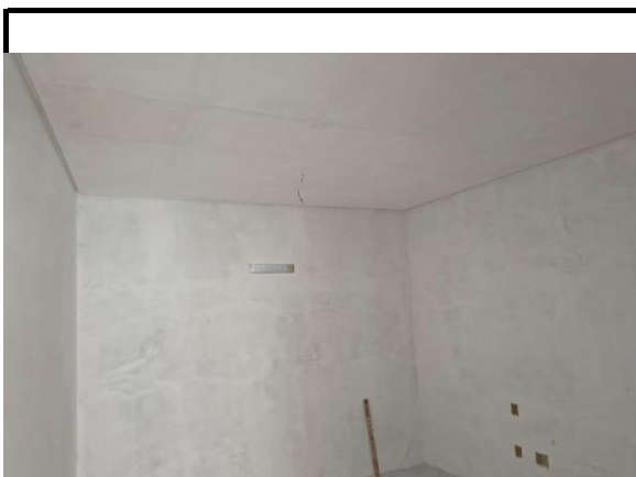
EMASSAMENTO DE PAREDES INTERNAS 2 DEMÃOS C/MASSA DE PVA
