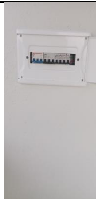
QUADRO DE DISTRIBUIÇÃO DE LUZ EMBUTIR ATÉ 12 DIVISÕES 207X332X95mm, C/BARRAMENTO
