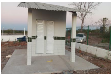
TELHA DE FIBROCIMENTO ONDULADA E= 8mm, INCLINAÇÃO 27%
