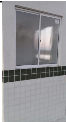
JANELA EM ALUMÍNIO ANODIZADO NATURAL/FOSCO, DE CORRER, SEM BANDEIROLA E/OU PEITORIL, SEM VIDRO - FORNECIMENTO E MONTAGEM
