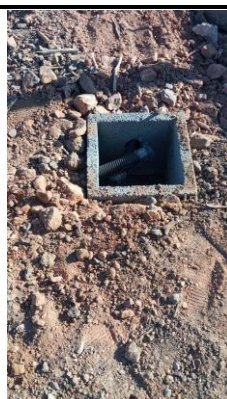
CAIXA DE INSPEÇÃO EM CONCRETO PRÉ-MOLDADO DN 60CM COM TAMPA H=60CM - FORNECIMENTO E INSTALAÇÃO
