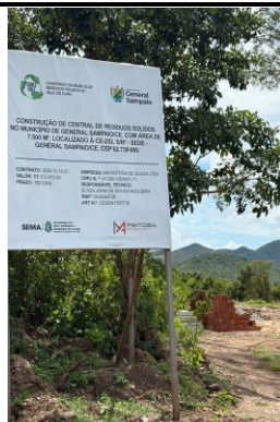
PLACA PADRÃO DE OBRA, TIPO BANNER
