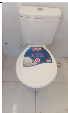
PONTO SANITÁRIO, MATERIAL E EXECUÇÃO
