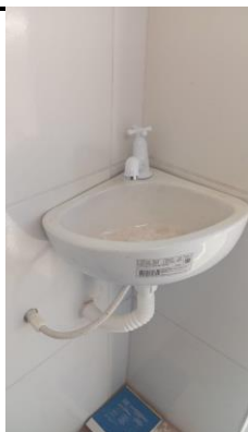
PONTO HIDRÁULICO, MATERIAL E EXECUÇÃO
