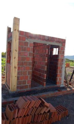
VERGA RETA DE CONCRETO ARMADO
