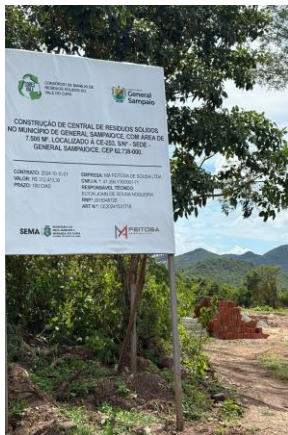
PLACA PADRÃO DE OBRA, TIPO BANNER
