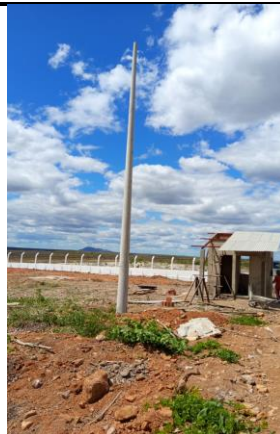
LUMINÁRIA 4 PÉTALAS EM POSTE DE CONCRETO CIRCULAR H=12M, ALTURA LIVRE 10,20M, LÂMPADA VAPOR METÁLICO DE 400W, INCLUSIVE O POSTE
