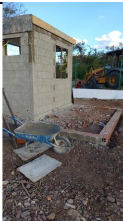
ALVENARIA DE VEDAÇÃO DE BLOCOS VAZADOS DE CONCRETO DE 19X19X39 CM (ESPESSURA 19 CM) E ARGAMASSA DE ASSENTAMENTO COM PREPARO MANUAL.
