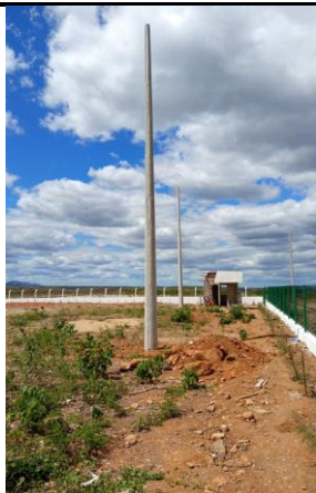
POSTE DE CONCRETO DUPLO T, RESISTÊNCIA NOMINAL 200KG, H= 8,00M, PESO APROXIMADO 400KG
