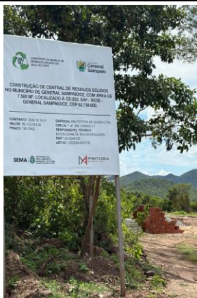
PLACA PADRÃO DE OBRA, TIPO BANNER
