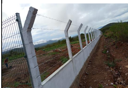
CERCA DE ARAME FARPADO 7 FIOS, MURETA C/ ALTURA DE 0,70M - FUNDAÇÃO E REBOCO NAS 2 FACES
